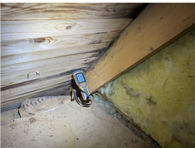
Exempel fuktfläck underlagstak, sidovind (inga avvikande värden)
