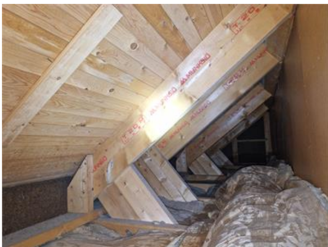
Sidovind sydväst, översiktsbild.
