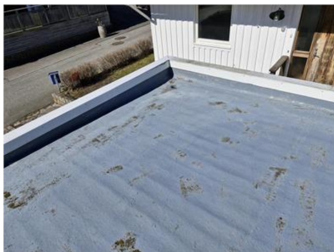
Tak Garage (hårdplast), låglutande med inbyggt stuprör.
