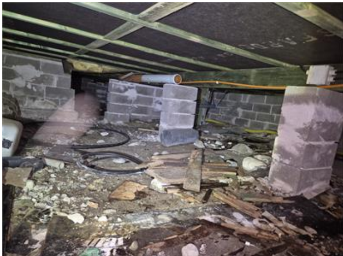
Bild från krypgrunden.
