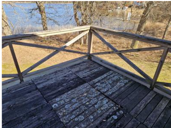
Terass: Räckets utformning medför fallrisk (avser i första hand barn)
