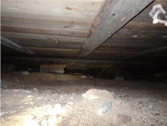
Exempel på mikrobiell påväxt på blindbotten i torpargrund.
