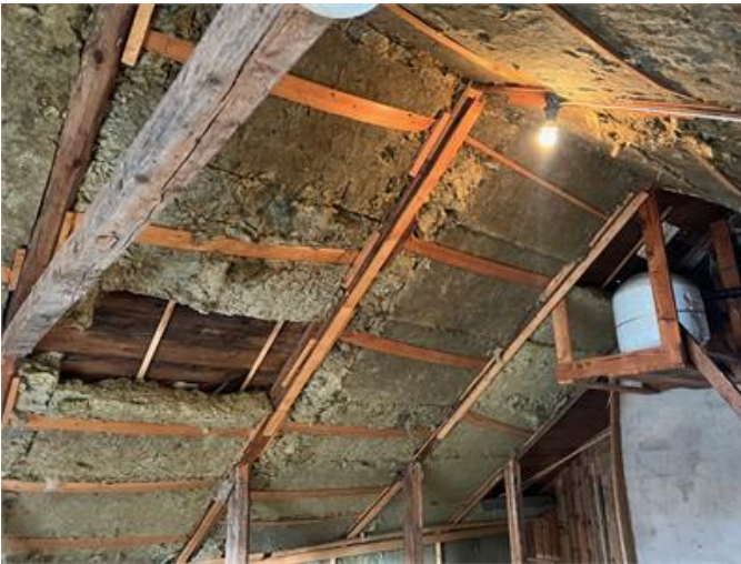
Bilderna visar delar av vindsutrymmet.
