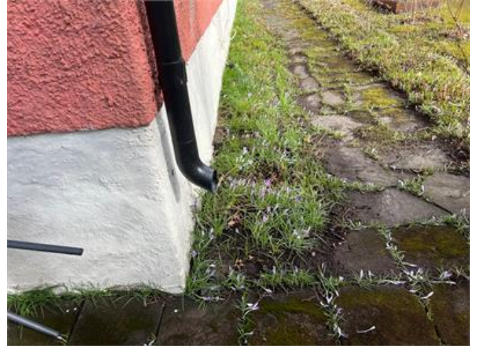
Stuprör ej anslutna till markledning
