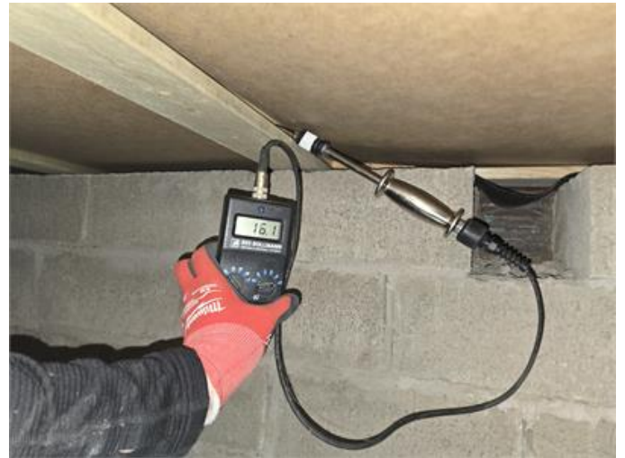
Exempel på fuktmätning i krypgrund.
