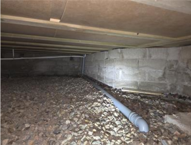
Överblick del av krypgrund.
