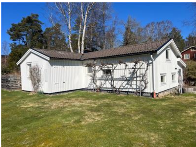
Taktäckningen är av äldre datum.
