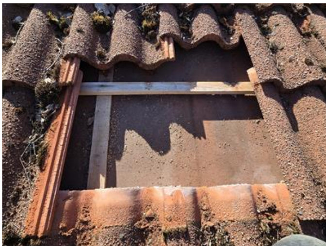
Tak: Stickprovskontroll under pannor, tunna ströläkt samt frömjöl/löv noterades.
