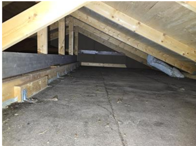
Nockvind: Översiktspild, äldre papptak noteras under nyare takstolskonstruktion.
