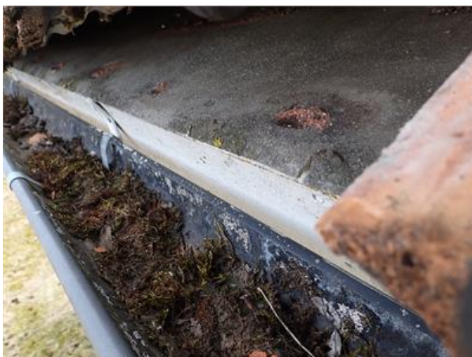
Nedre del av tak där takpannor vilar på pappan.
