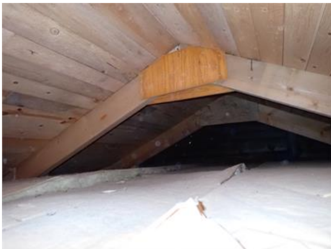
Vy över vindsutrymmet.
