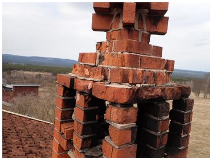
Skorsten som eroderat och innehåller eldningsförbud.
