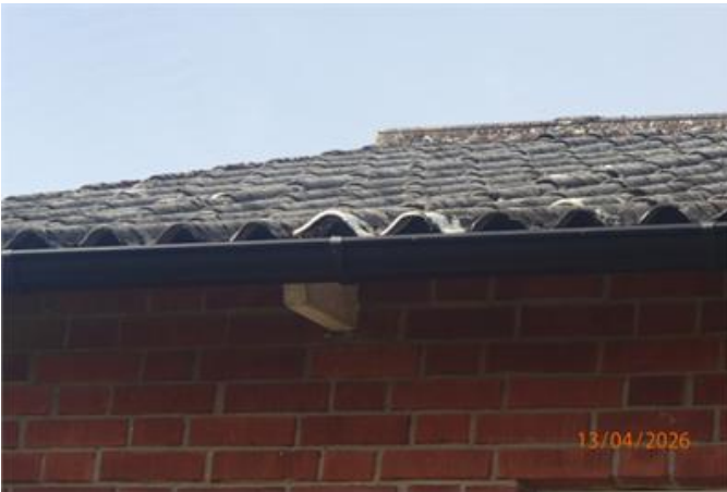
Bild på fiber cement skivor som börjar vittra sönder.
