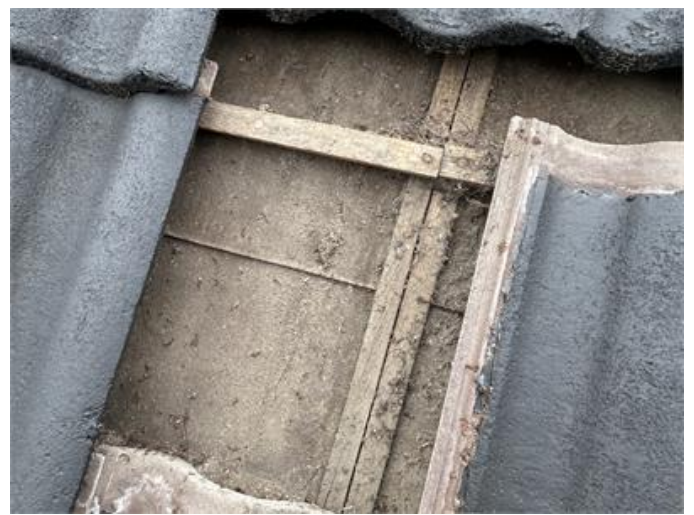
Tak: Teknisk livslängd passerad.
