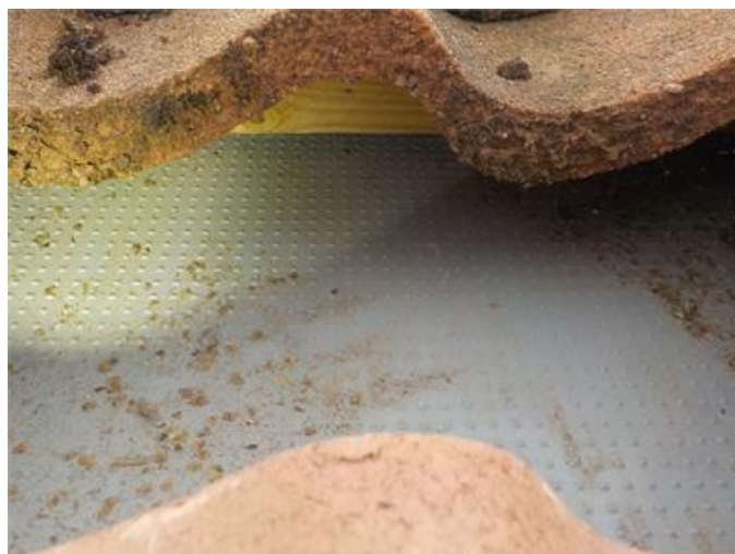
Bild på takpannor - läkt och underlagsduk.
