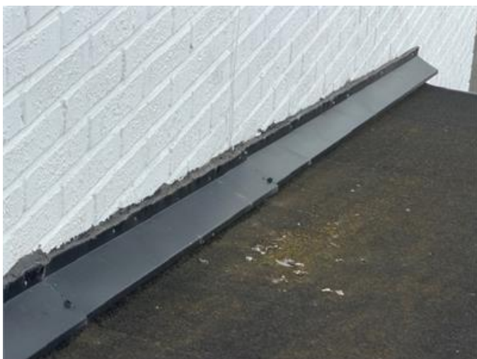
Plåtanslutning mellan garage och hus
