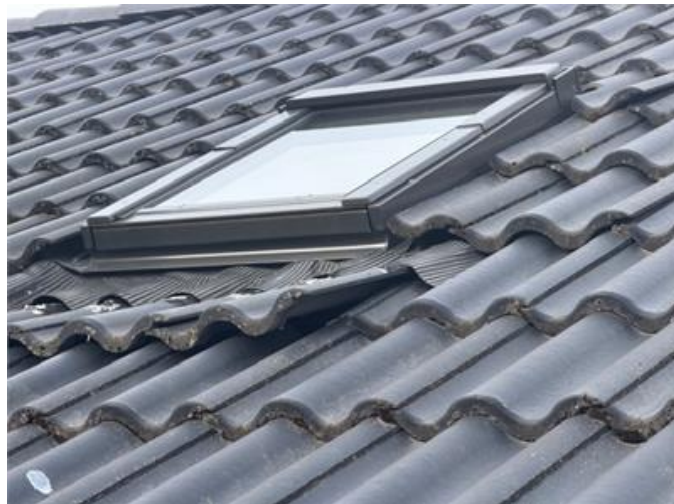
Takpannor vid takfönster
