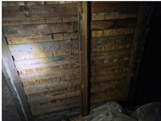
Vy på underlagstak
