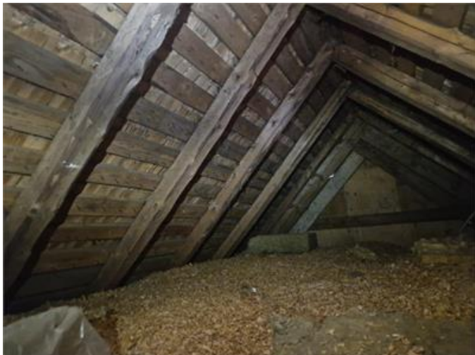
Vy på vindsutrymmet
