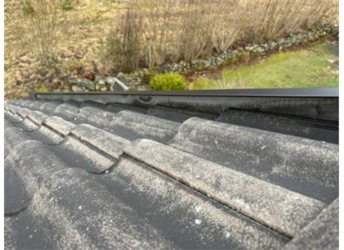
Bilden visar vindskiva/plåt som är ur sitt rätta läge.
