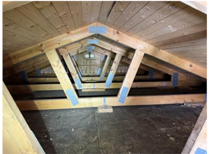
Översiktsbild vind ovan garage
