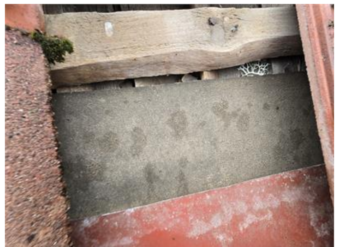
Tak: Övergång mellan plåt/pannor, underlagspapp ligger upp på träspån.
