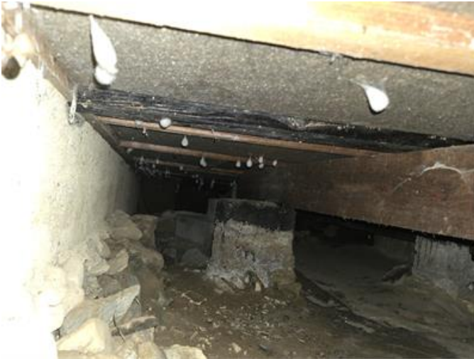
Krypgrund: Översiktsbild från ventil.
