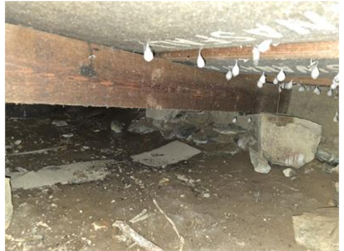
Krypgrund: Översiktsbild från ventil.
