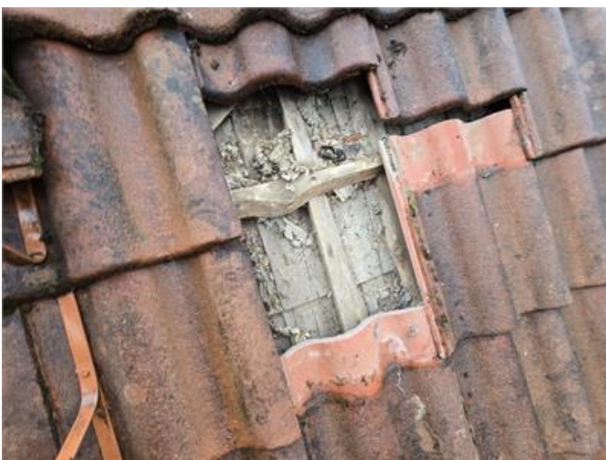
Tak: Stickprovskontroll under pannor, mycket skräp samt träspån som underlagstak.
